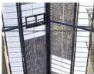
Les capteurs photovoltaïques sont intégrés à la verrière de la galerie de circulation d'une résidence HCM. L'Isle d'Abeau (Isère) © Phoboslab
