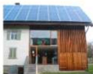
Un ensemble de capteurs recouvre toute la surface du toit, comme une nouvelle couverture. Orche à Zerscherweiser (Vorarlberg, Autriche) © CAUE 78
